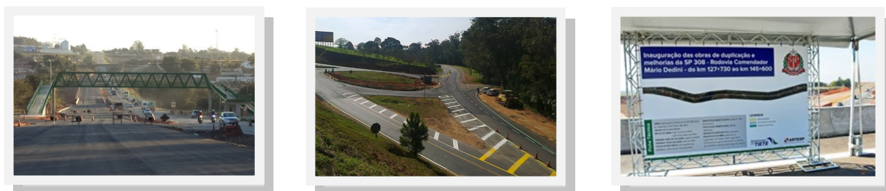
Demais Obras em Andamento.
