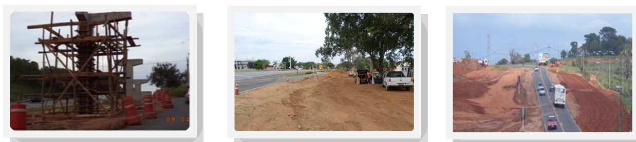
Demais Obras em Andamento em 2014
