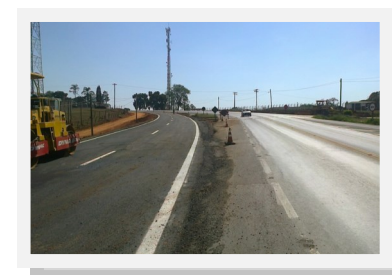
Demais Obras em Andamento em 2014
