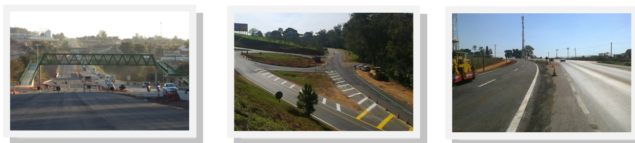
Demais Obras em Andamento em 2014
