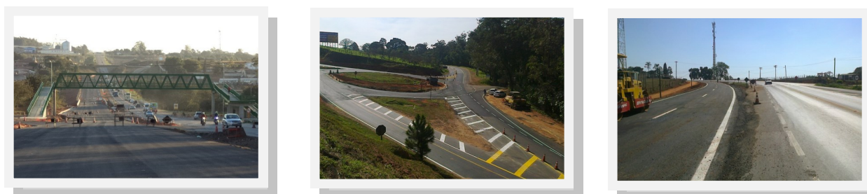
Demais Obras em Andamento em 2014
