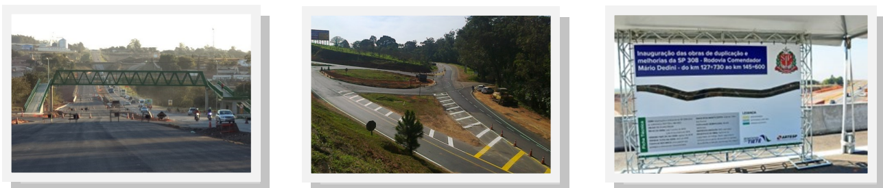
Demais Obras em Andamento.
