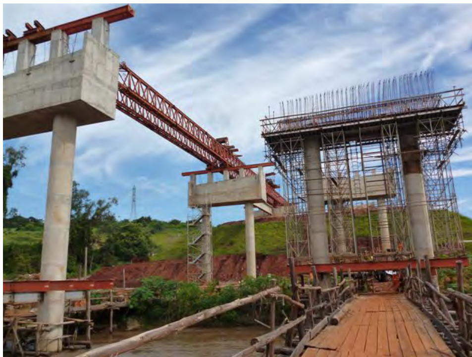
Fotografia 4- Viaduto no Rio Piracicaba. Fonte: Relatório de andamento, março de 2013
