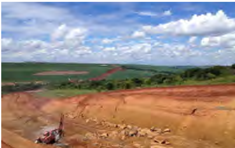
Figura 4 Obras de construção da SPI-162/308 (Contorno de Piracicaba )
