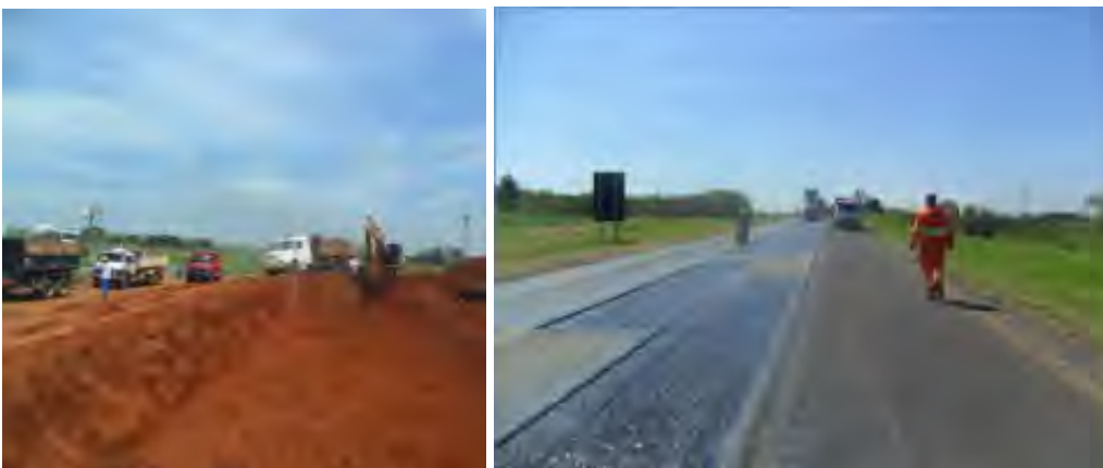
Fotografia 3 – Esquerda: Terraplanagem em na duplicação da SP-308. Direita: Andamento da pavimentação da duplicação da SP-308. Fonte: Relatório de andamento, dezembro de 2012
