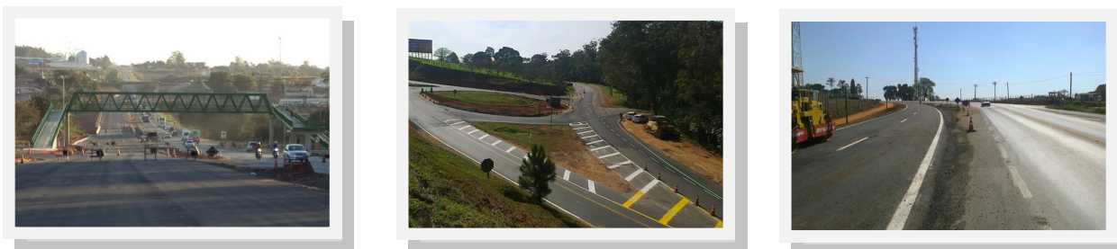
Demais Obras em Andamento em 2014
