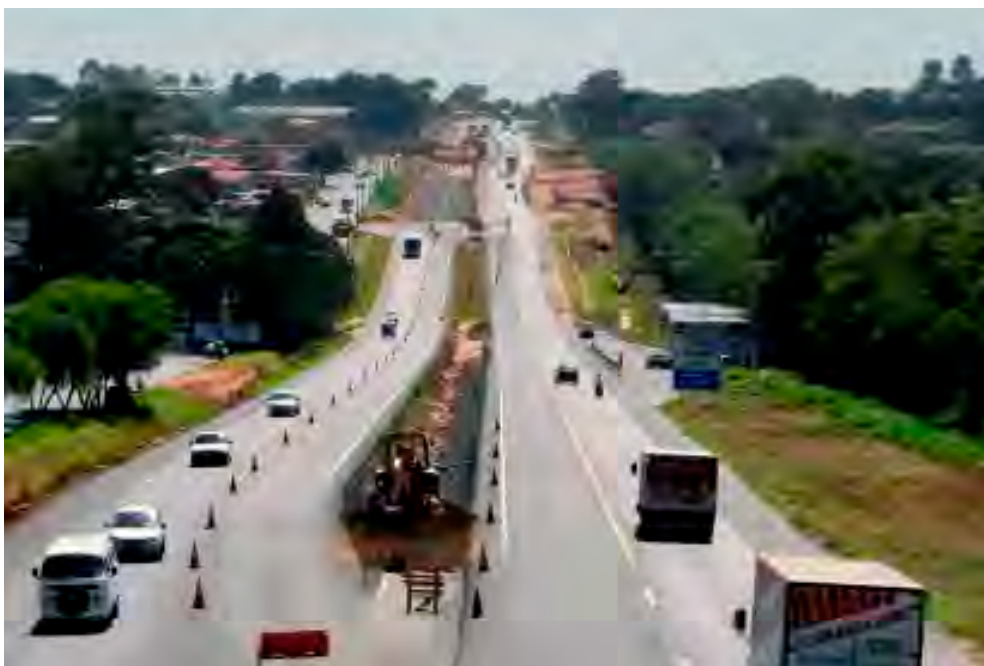
Fotografia 5 - Obra de alargamento da SP-101, fevereiro de 2013. Fonte: Site Rodovias do Tietê.
