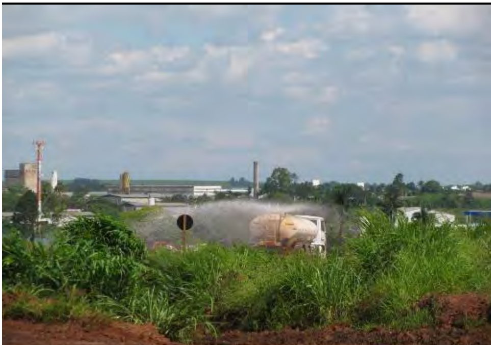
Foto 24. Umedecimento do solo na frente de trabalho com caminhão pipa para impedir suspensão de poeira.
