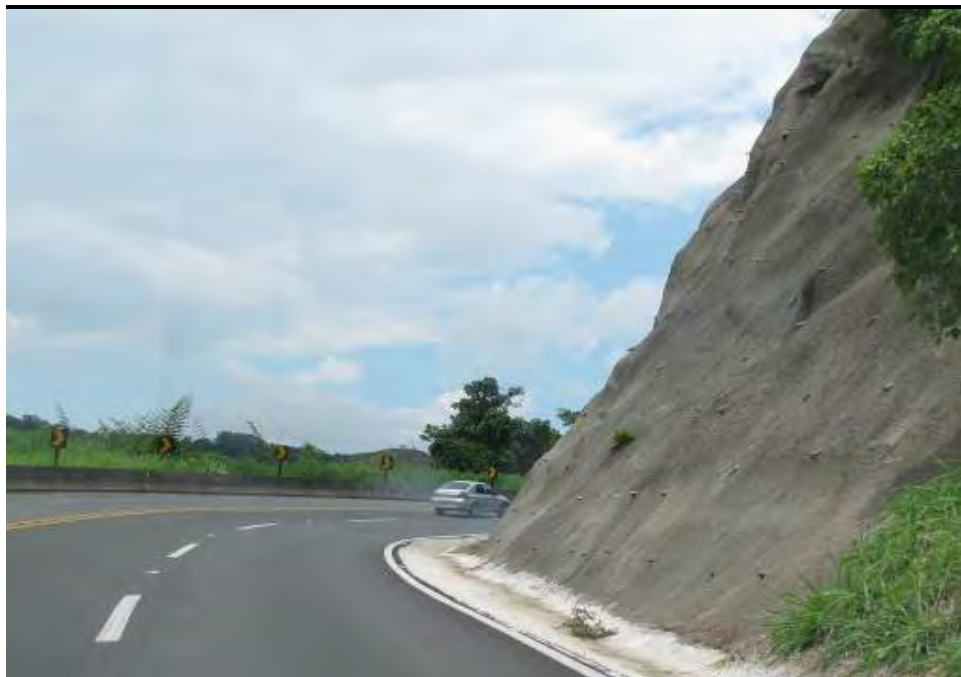
Foto 28. Área da Serra de Botucatu, com proteção contra deslizamento de terra, feita com concreto projetado.
